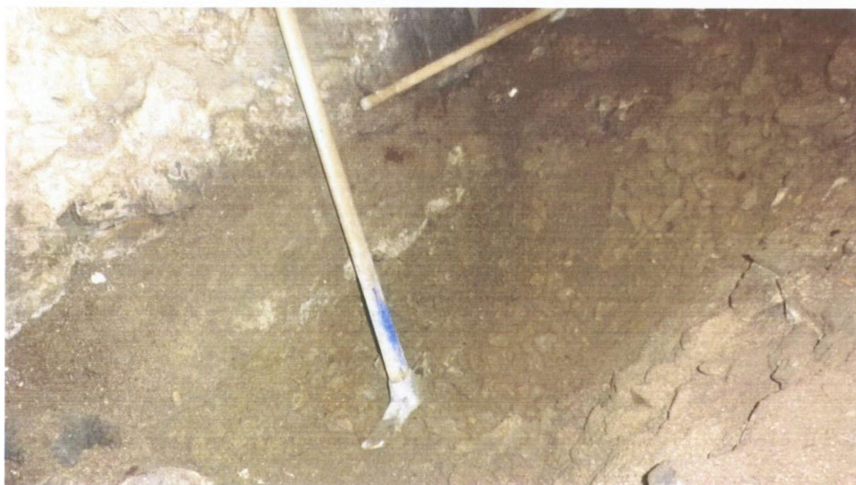
Obrázek 10 Gotický sklep_sonda 2 - Úroveň základové spáry na skalním podloží
