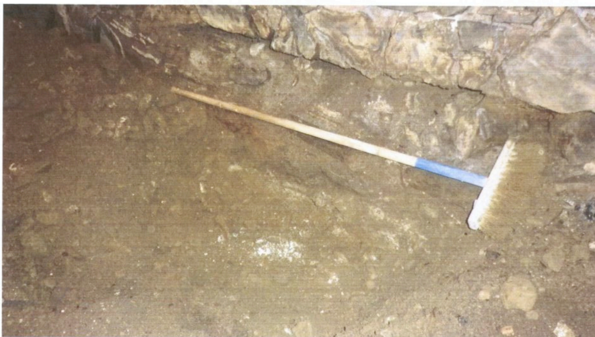
Obrázek 12 Detail základové spáry gotický sklep_sonda 1 – Základ je založen na skalním podloží
