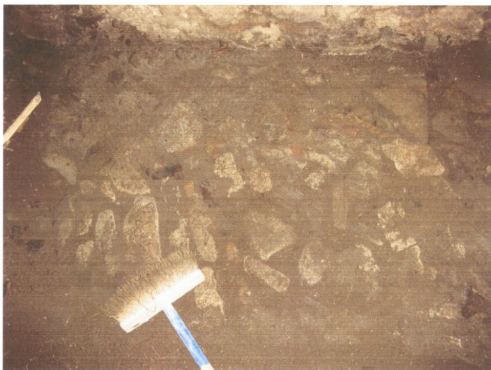
Obrázek 8 Uložení původní dlažby ve sklepních prostorech
