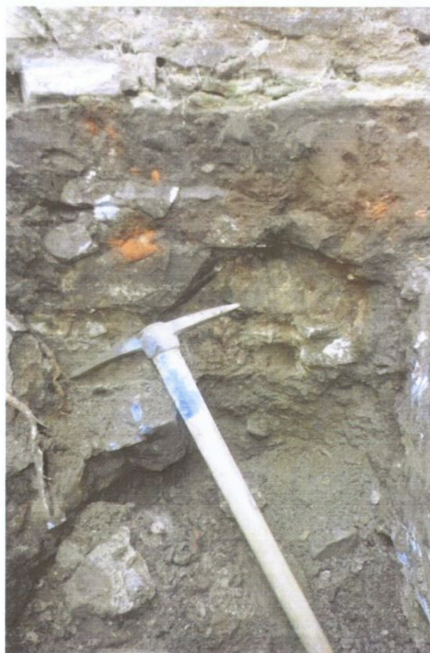
Obrázek 2 Sonda („kanalizace“) pod komínem, založení 0,5 m pod povrchem
