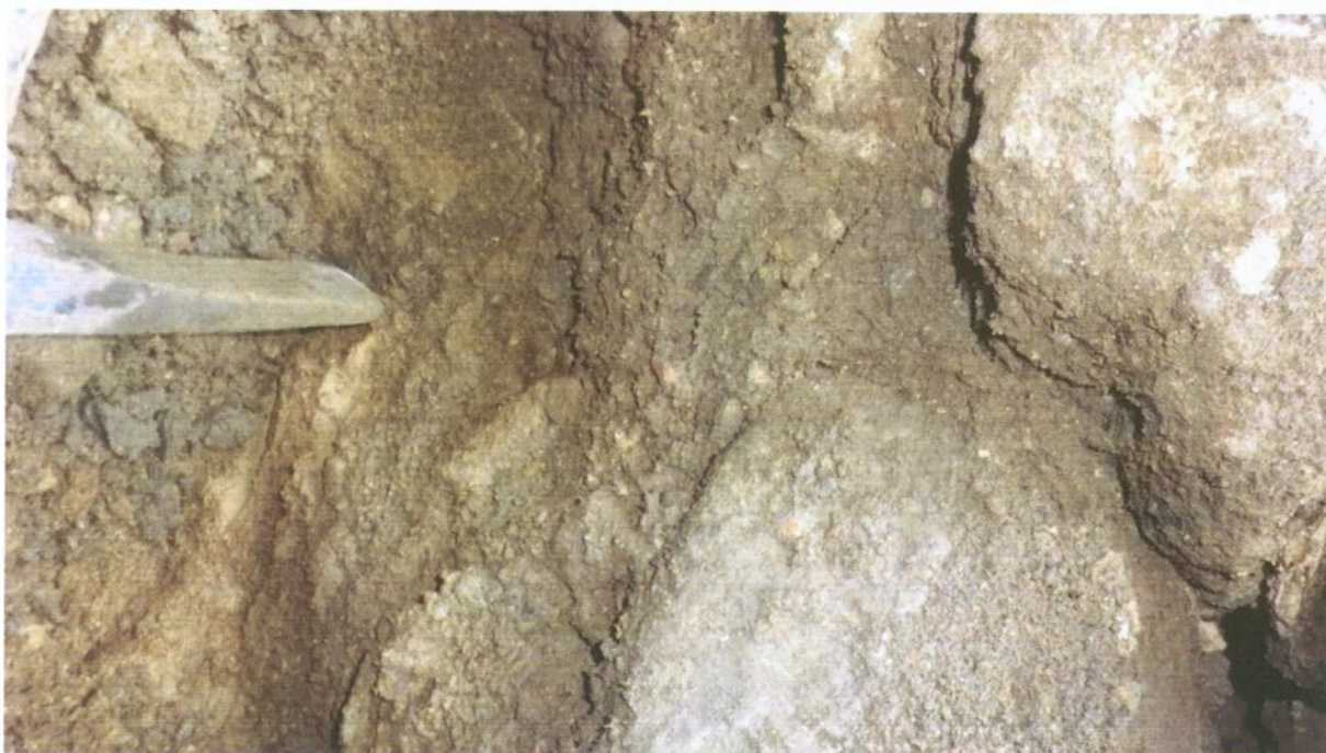
Obrázek 6 Detail podzákladí - podložní štěrkopísek terasy a rozvětralého rulového skalního podkladu
