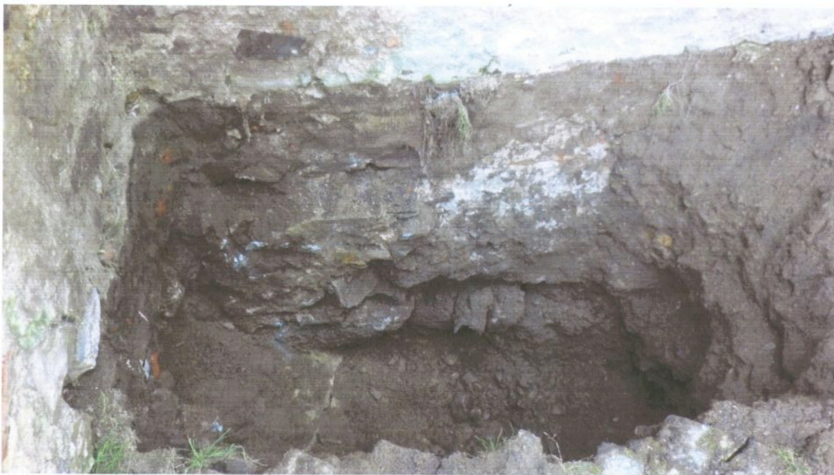
Obrázek 5 Strana přilehlá k objektu, na obrázku patrný prostup pod základem litinovou trubkou („sonda výtah“)
